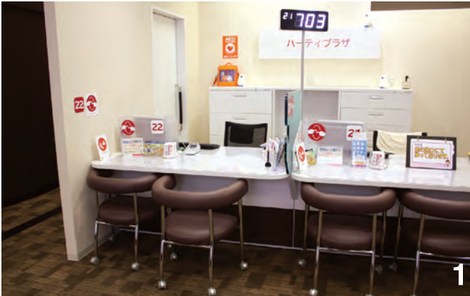
[サービスカウンター] 車いす使用者や高齢者が座って対面に対応できるサービスカウンター。介助者も座れる幅と、足元の奥行きが確保されている。
